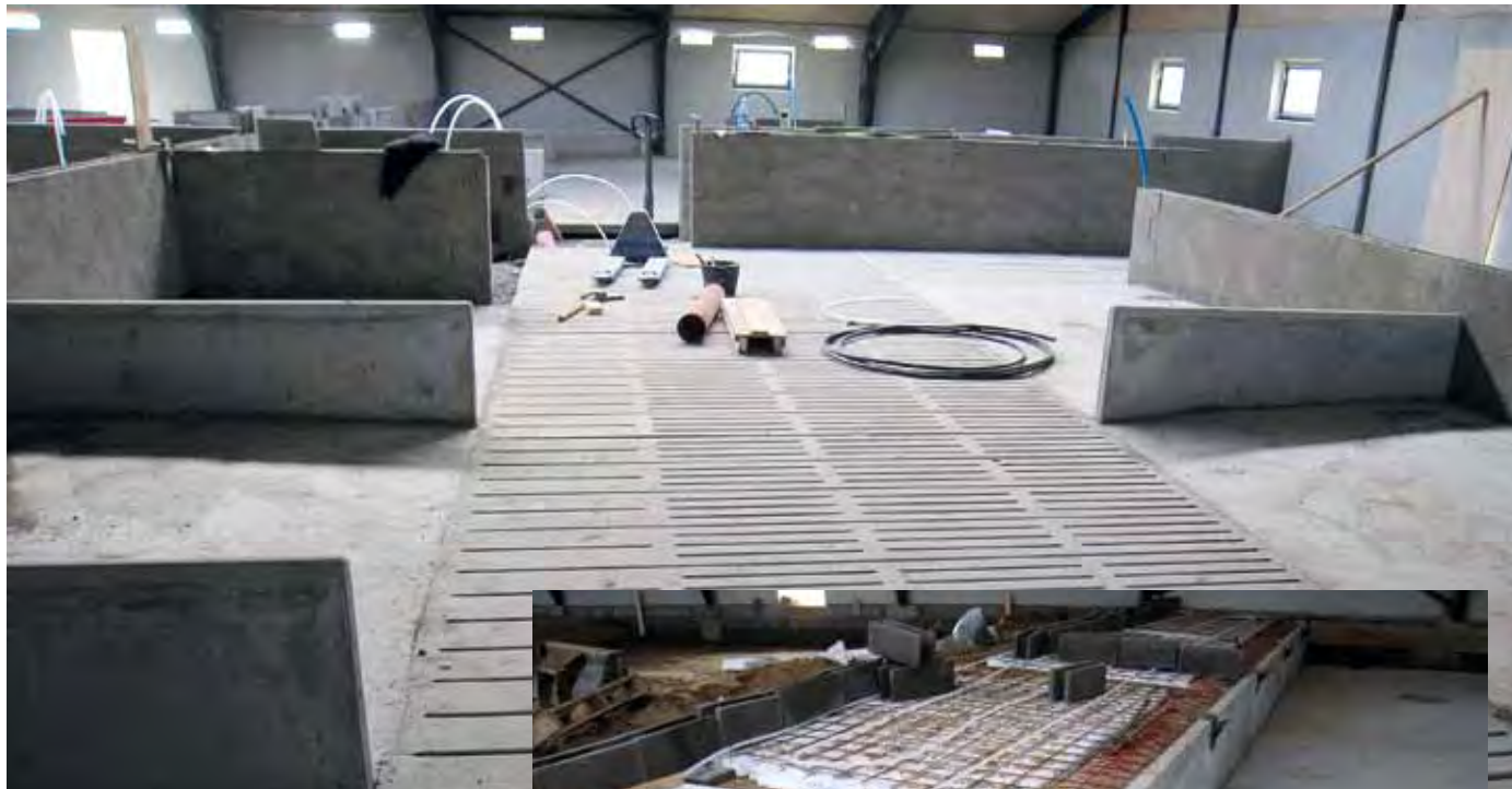
Placering af dyser og tværkanal i en drægtighedsstald med ESF. Punktudsugningskanalen ligger lige under det faste gulv ved overgang til gødningskumme.
