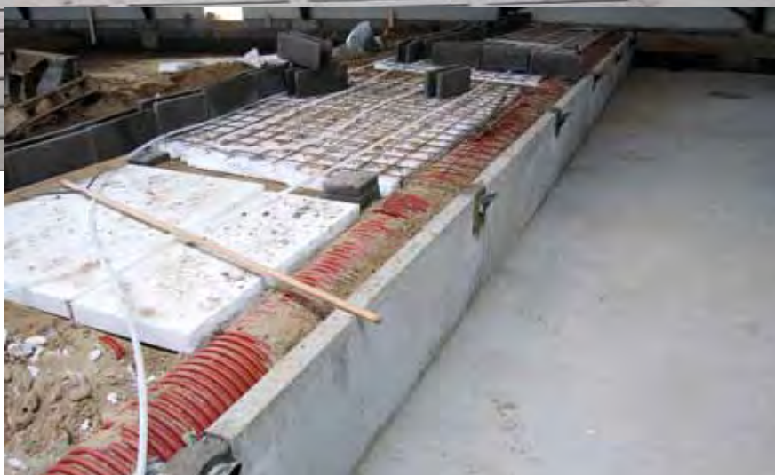
Placering af dyser og tværkanal i en drægtighedsstald med ESF. Punktudsugningskanalen ligger lige under det faste gulv ved overgang til gødningskumme.
